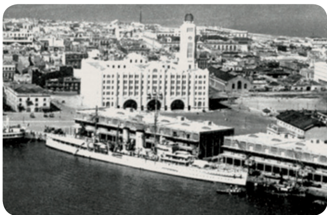
El HMS Exeter en el puerto de Montevideo de visita en 1934. HMS Exeter Montevideo harbor during its visit at 1934.
